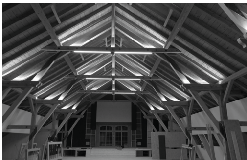
Eclairage intérieur de la grande salle, au moyen de barres de lumière LED.
