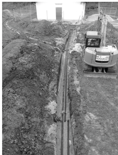
Pose des conduites pour acheminer l'eau thermique entre le puits et notre bâtiment.
