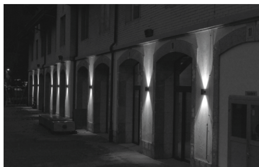
Nouvel éclairage extérieur, sur la façade du côté de la route de Pierre-Pertuis
