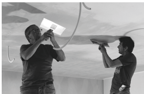
Travaux de masticage et de lissage (1er étage), avant le ponçage puis peinture des plafonds.
